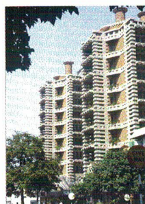
Des centaines de trous d'aération, 48 cheminées : la ventilation de l'Eastgate Centre de Harare (Zimbabwe) est calquée sur celle d'une termitière.
